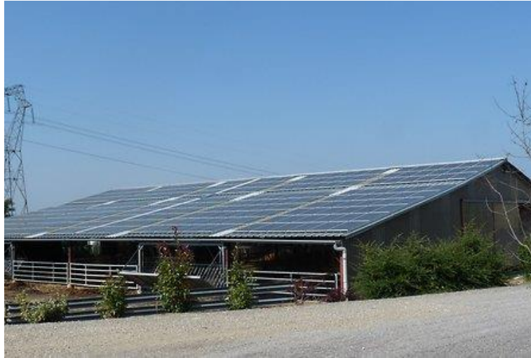
Installation photovoltaïque sur un bâtiment agricole
